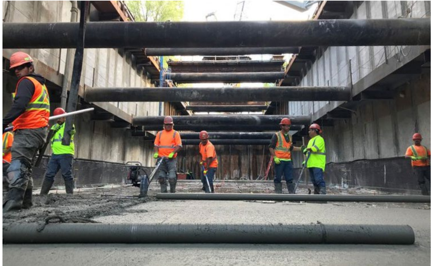
Crews pour the Kenilworth tunnel leveling slab
