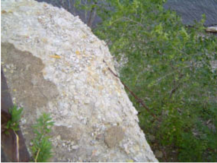
Pier 5: Concrete Cap Edge
