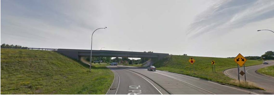
Figure 3: CSAH 42 and CSAH 17 Grade Separation
