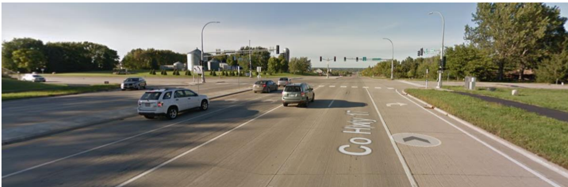
Figure 4: CSAH 17 and CSAH 78 Intersection
