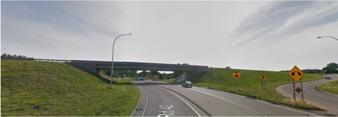
Figure 3: CSAH 42 and CSAH 17 Grade Separation
