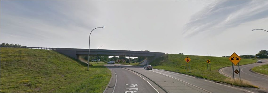
Figure 3: CSAH 42 and CSAH 17 Grade Separation
