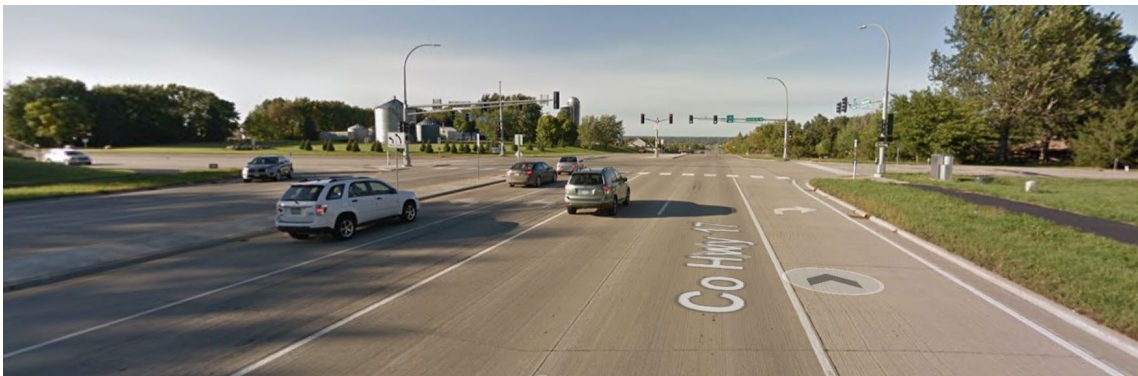
Figure 4: CSAH 17 and CSAH 78 Intersection
