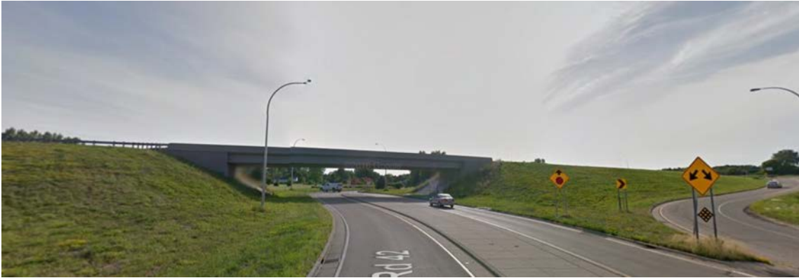
Figure 3: CSAH 42 and CSAH 17 Grade Separation
