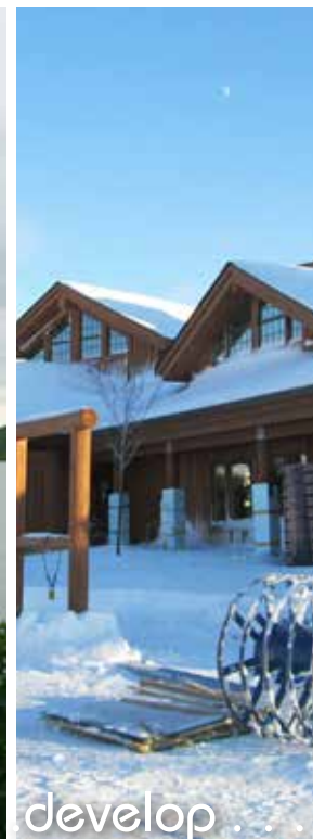
Tettegouche Visitor Center
