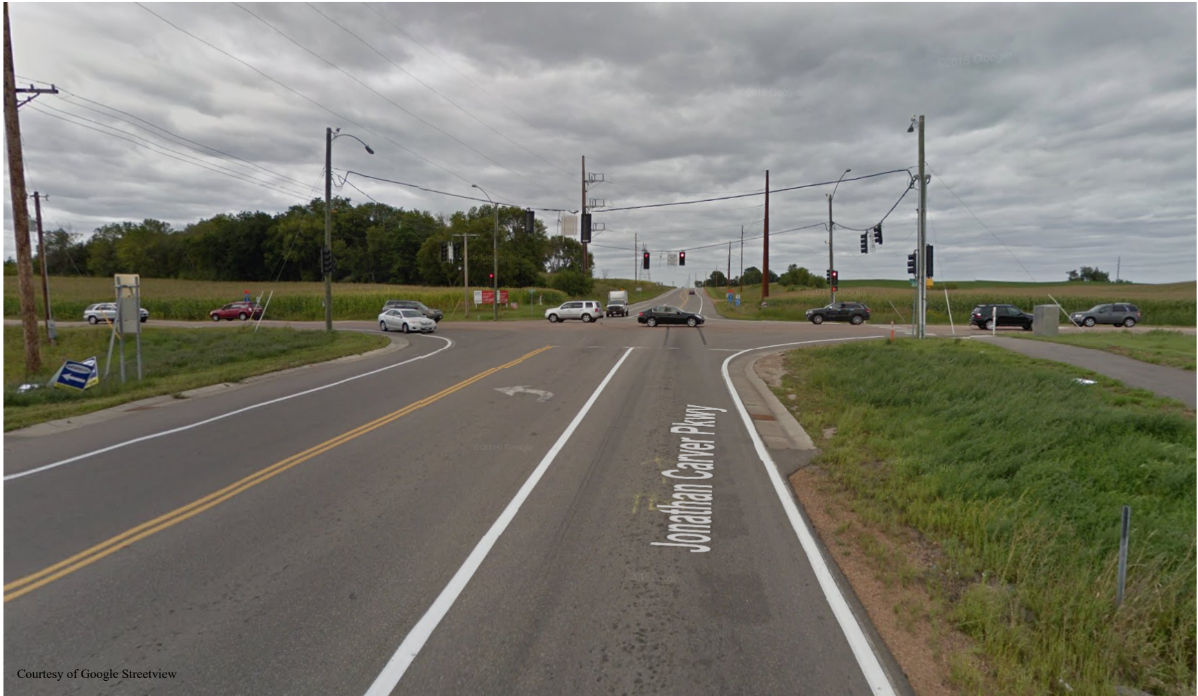
CSAH 10 at CSAH 11 Intersection Existing Conditions – CSAH 11, looking north
