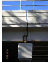
12. pier S.side joint_2.jpg
