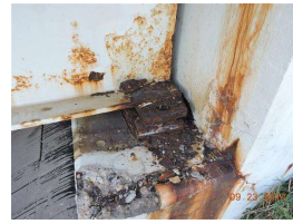
19. NE abut bearing anchor bolt 007.JPG
