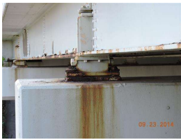
21. NE pier 2 bearing 014.JPG
