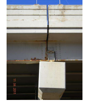
10. pier N.side joint_2.jpg
