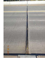
9. pier N.side joint_1.jpg
