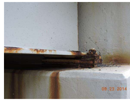
23. SW abut bearing anchor bolt 032.JPG
