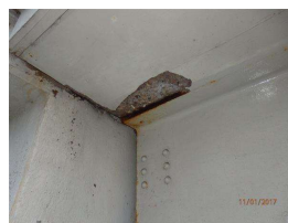
33. SE corner Deck.JPG
