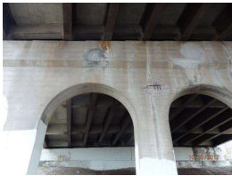
11. N pier W end.JPG
