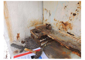
20. NW abut bearing anchor bolt 001.JPG
