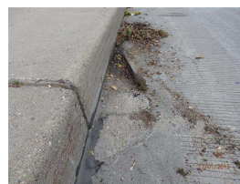
32. NE Approach panel.JPG
