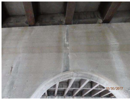
16. S pier cap midspan (1).JPG
