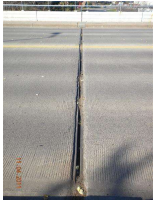
11. pier S.side joint_1.jpg
