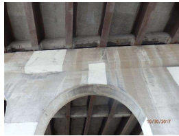
17. S pier cap midspan (2).JPG
