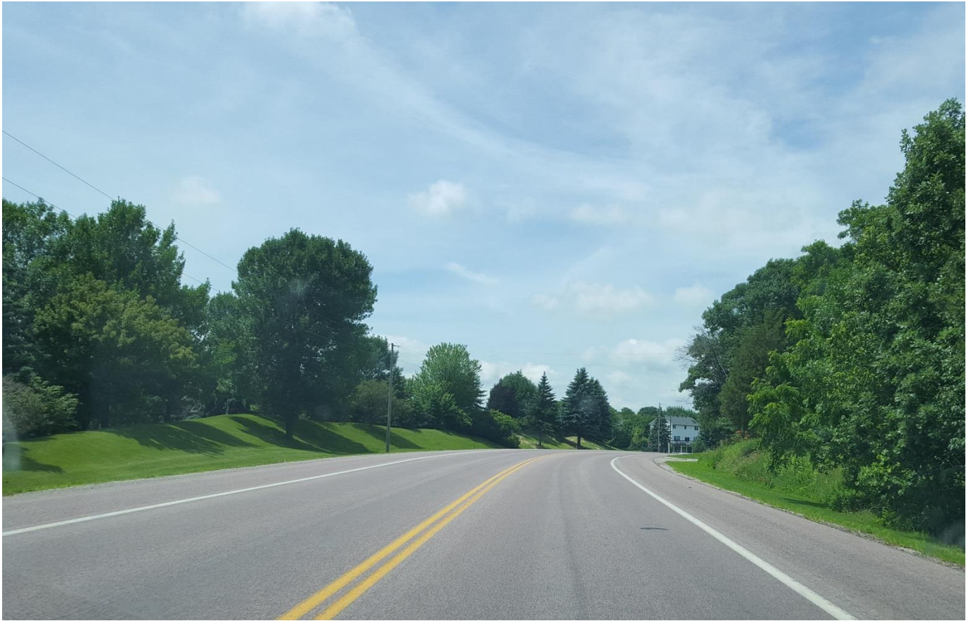
CSAH 16 - looking west
